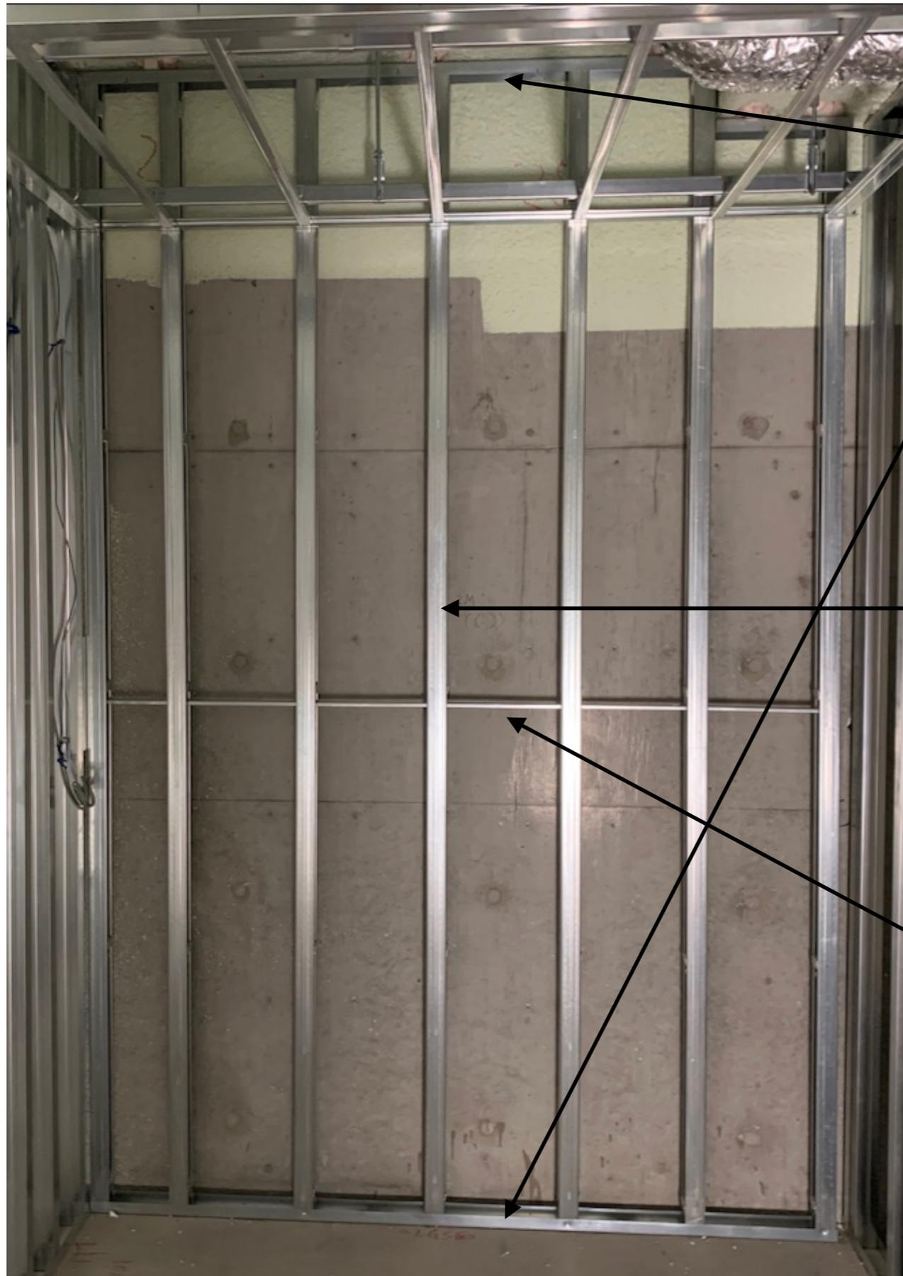
**ランナー**（スタッドの上下はランナーに差し込む）ランナーとはコの字状の鉄板で出来た材料で、ランナーは、打ち込みピン等で床、梁下、スラブ下等に固定する。そしてスタッドを上下のランナーに差し込み間仕切りが作られます
