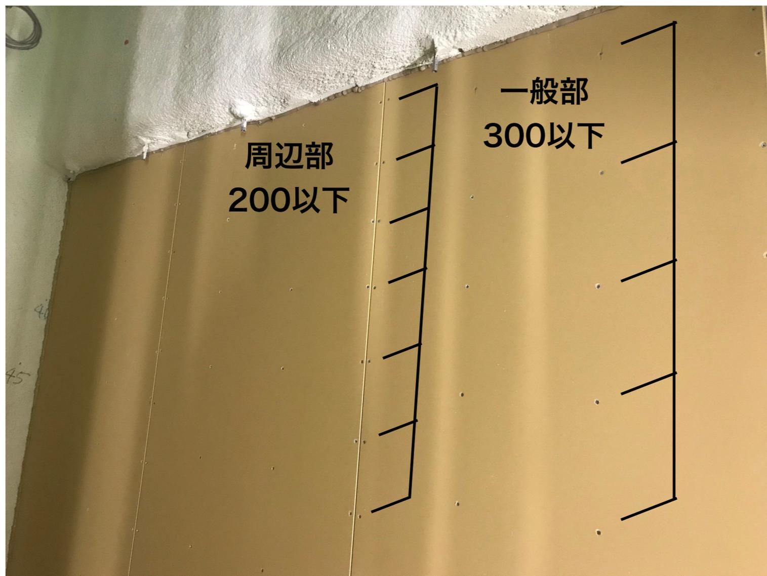
公共建築工事標準仕様書及び石膏ボード施工マニュアルにおいては、留付け具（ビス）のピッチは左下表に示すように、壁に関しては、ボード周辺部は200mm以下、一般部は300mm以下となっておりますが、石膏ボード1枚張りの場合はビスのピッチはこれより短くすることを推奨します。
